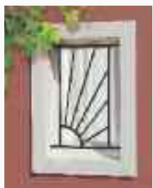
Grille de fenêtre
