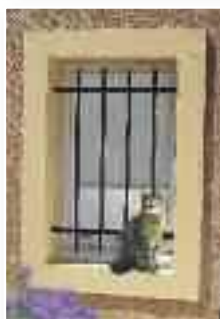
Grille de fenêtre
