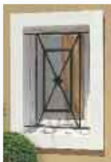
Grille de fenêtre
